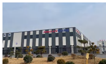
河南西华生产基地 Henan production base
